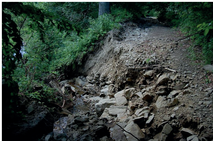
Obr. 5.2.12. Vrchná časť pripovrchovej zóny rozvoľnenia hydrogeologického masívu (magurské súvrstvie) odkrytá na brehu a dne potoka (koryto potoka Tokáreň – sedlo Lysina, 1 029 m n. m.; foto: www.cergov.sk).
